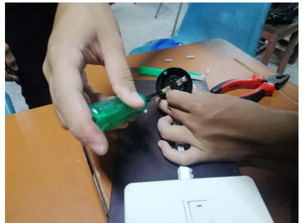
ขั้นตอนที่ 11 (ต่อสายไฟเข้าฐานหลอด)
