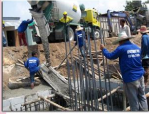
ก่อสร้าง
